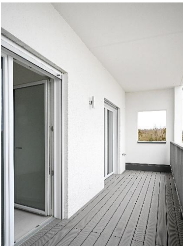
Loggia mit WPC-Belag
